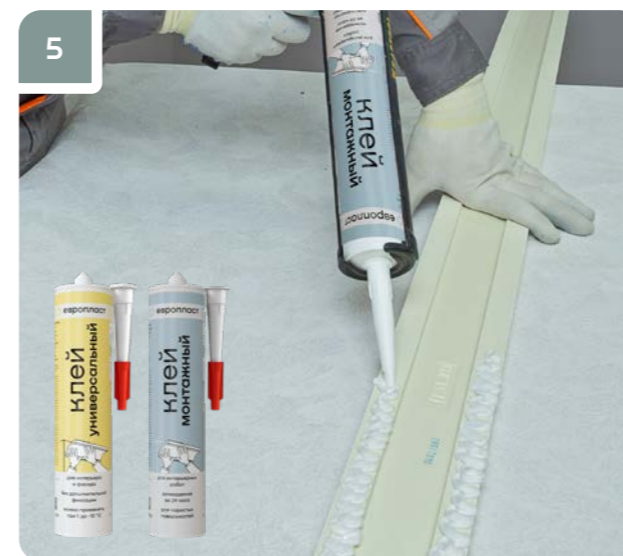
5 Равномерно нанести на монтажную поверхность клей «Европласт Монтажный» или клей «Европласт Универсальный» по всей длине изделия. Толщина наносимого слоя клея должна составлять 3-5 мм.
