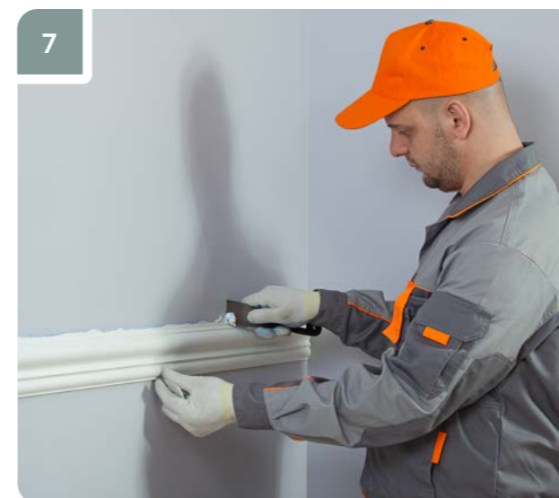
7 Сразу после приклеивания удалить выступившие излишки клея шпателем.
